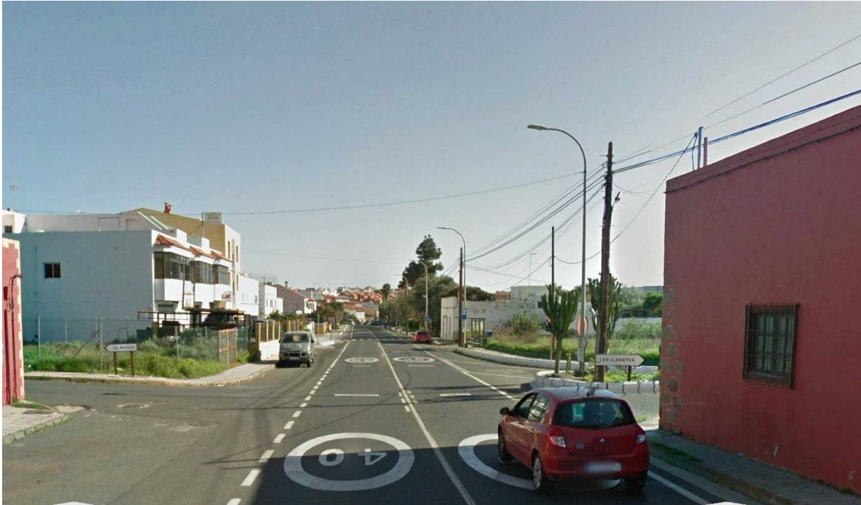
Figura nº 4. Vista de la GC-41 a la altura del sector donde es posible apreciar la prohibición de adelantamientos y la limitación de velocidad a 40 Kms/hora por la existencia de viviendas anejas a la vía. Igualmente se aprecia el bajo nivel de tránsito de vehículos en cualquier momento del día y las generosas dimensiones de la vía y de las aceras existentes.
